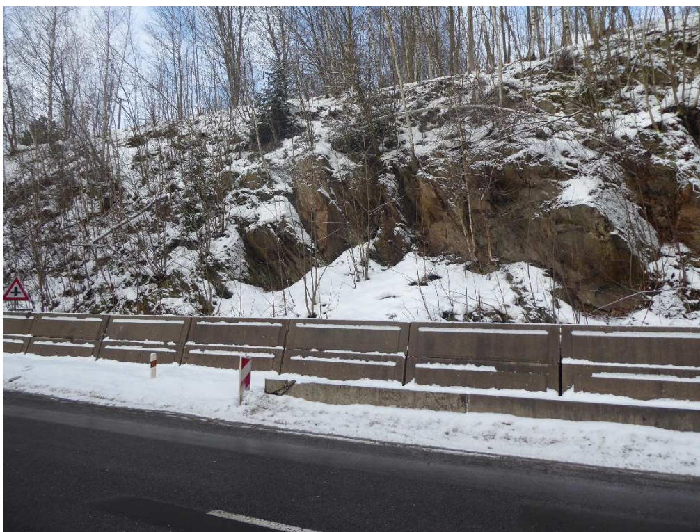
Začátek úseku sanace a dočasná bet. svodidla předsazena před zidkou.
