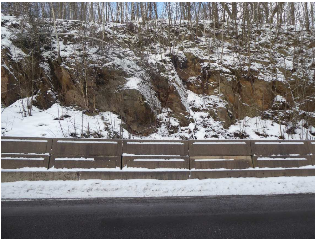
Skal. svah bude po odstranění náletu, očištění a odtěžení, zajištěn ocel. sítí.
